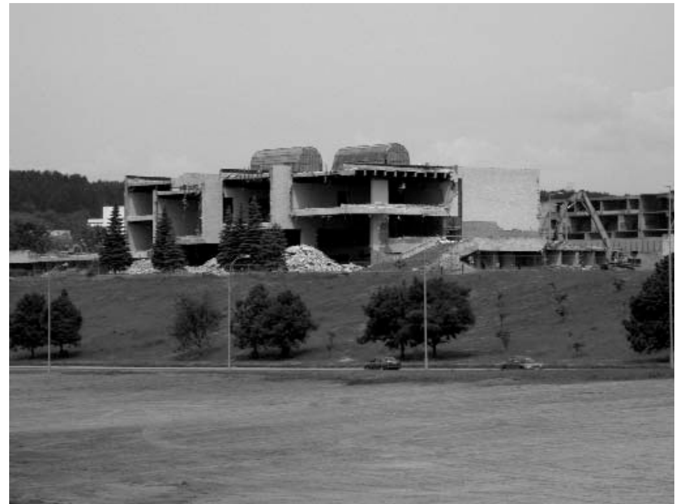
35. REKONSTRUOJAMAS NACIONALINĖS DAILĖS GALERIJOS PASTATAS VILNIUJE / BUILDING OF THE NATIONAL ART GALLERY IN VILNIUS UNDER RECONSTRUCTION. Fotografija / Photo: Mike Bode, 2005
