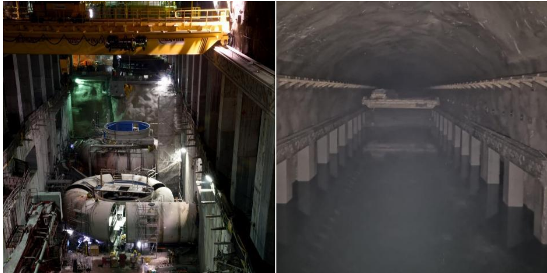
Figure 30 The moment the floodwaters entered the turbine hall, and the flooded aftermath on the 10th of May 2018 El Tiempo, ‘Foto revela el estado actual de la casa de máquinas de Hidroituango’ El Tiempo, February 10 2019, available at: https://www.eltiempo.com/colombia/medellin/foto-del-estado-actual-de-casa-de-maquinas-de-hidroituango-324514 (accessed March 2019).
